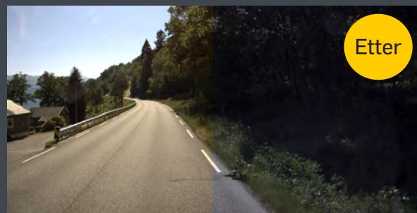
Langs fv. 7 er gammalt og rusta rekkverk skifta ut.
