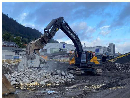
ELKRAFT: Maskinene som bygger Bybanen går på straum. Foto: Silje Christine Alvsaker, Vestland fylkeskommune. Les meir om prosjektet i klimamagasinet til fylkeskommunen. Den grønne leiartrøya
