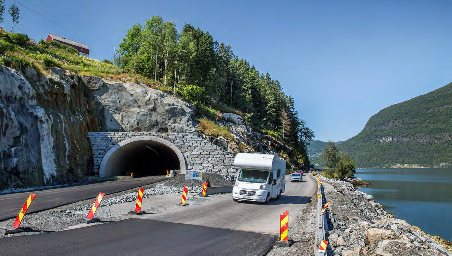
Olden-Innvik, foto: Silje Drevdal, Statens vegvesen
