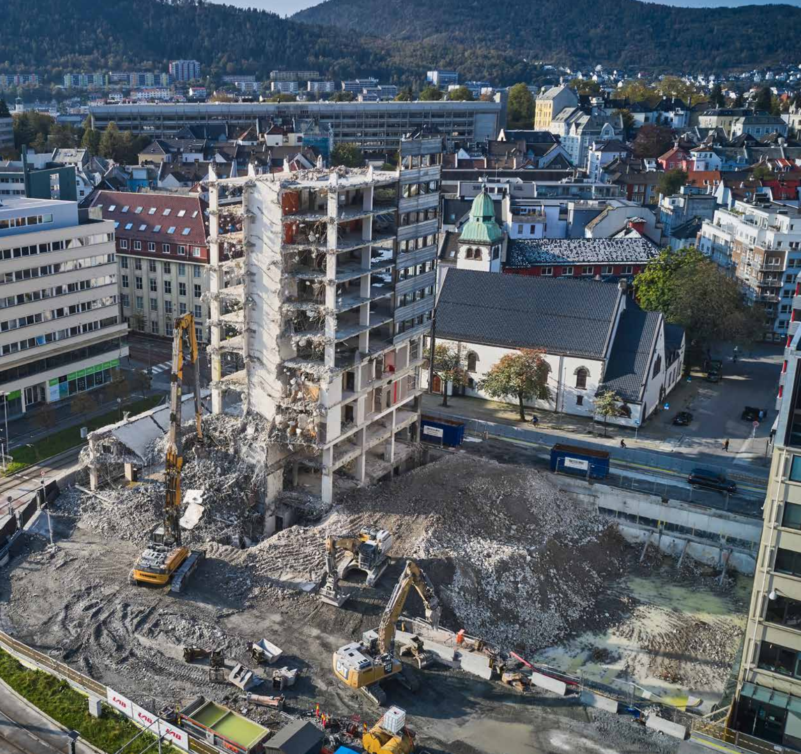
Riving av fylkeshuset i Bergen. Foto: Morten Warvik.
